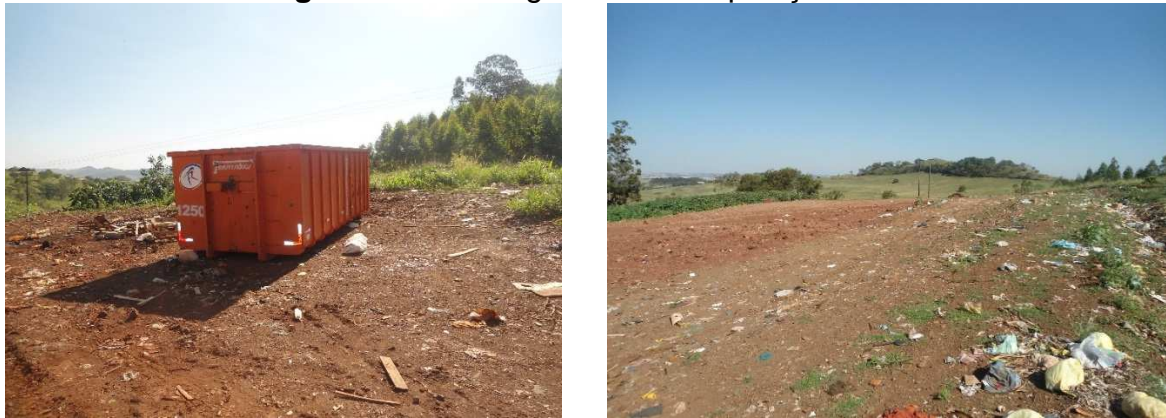
Figura 3.20 – Antiga área de disposição final
